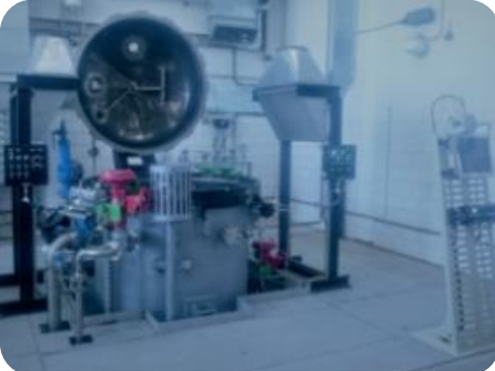
Vacuum impregnation line – VATT-5-VKP2.8.
